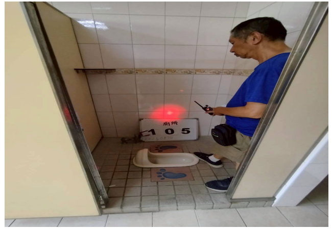
信義樓5號廁所偵測照片
