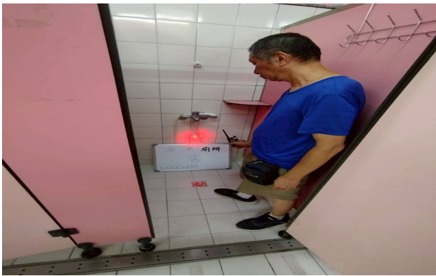
游泳池淋浴間偵測照片
