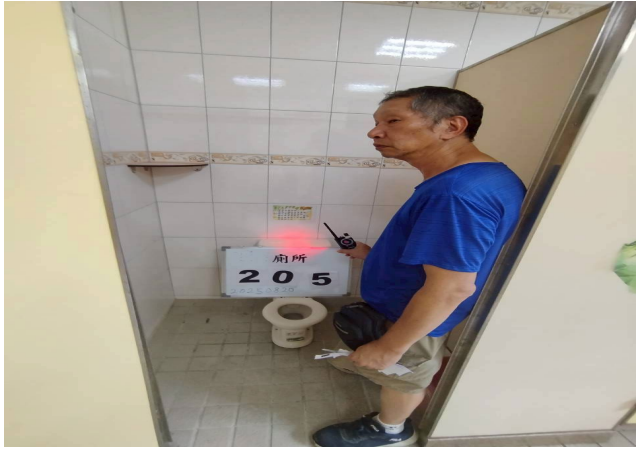
信義樓5號廁所偵測照片
