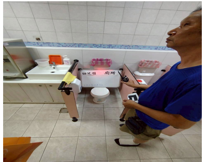
信義樓幼兒園廁所偵測照片
